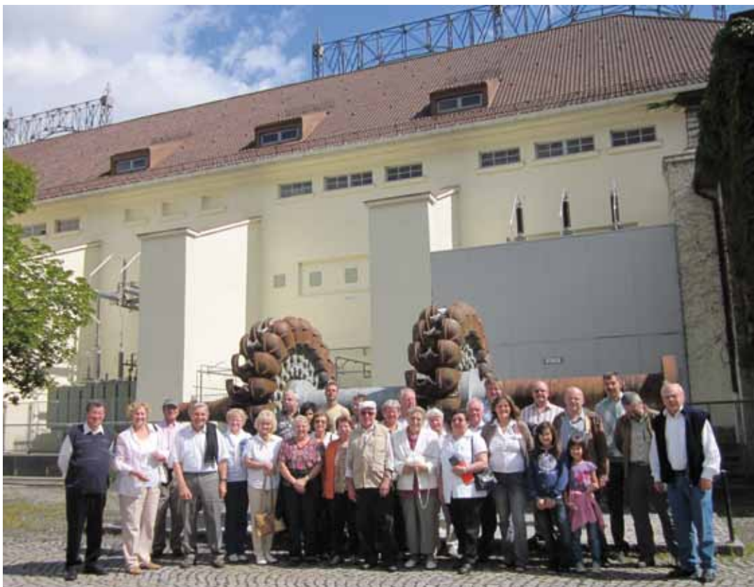
Das Bild zeigt die Bobinger Gruppe im Hof zwischen dem Krafthaus und dem Transformatorenhaus vor historischen Turbinen. Zweite von links Waltraut Wellenhofer, rechts außen Dipl. Ing. Karl-Ulrich Hägele.
